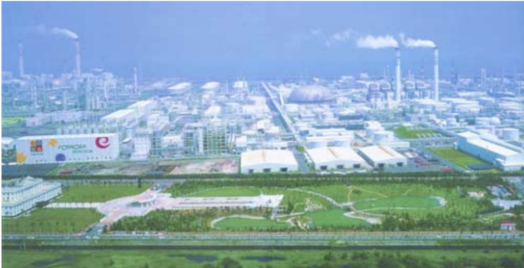
台塑六輕麥寮工業園區廠區圖（資料來源：石化工業雜誌）
