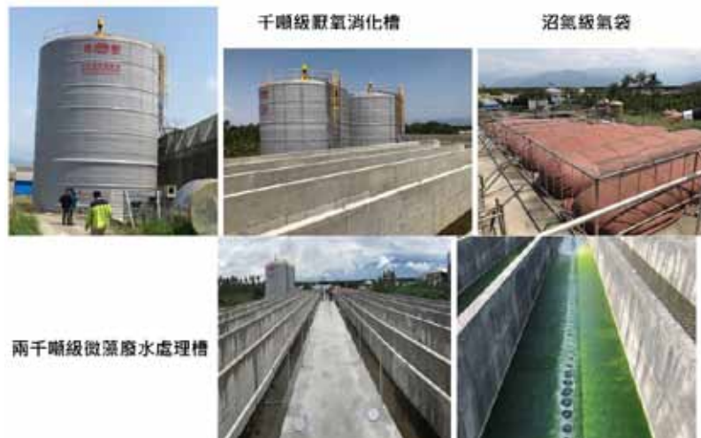
圖3、位於屏東中央畜牧場之畜牧廢水微藻處理系統
