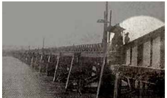
清代興建的臺北往新竹的淡水河橋， 右邊是可以水平旋轉的鋼樑結構。
