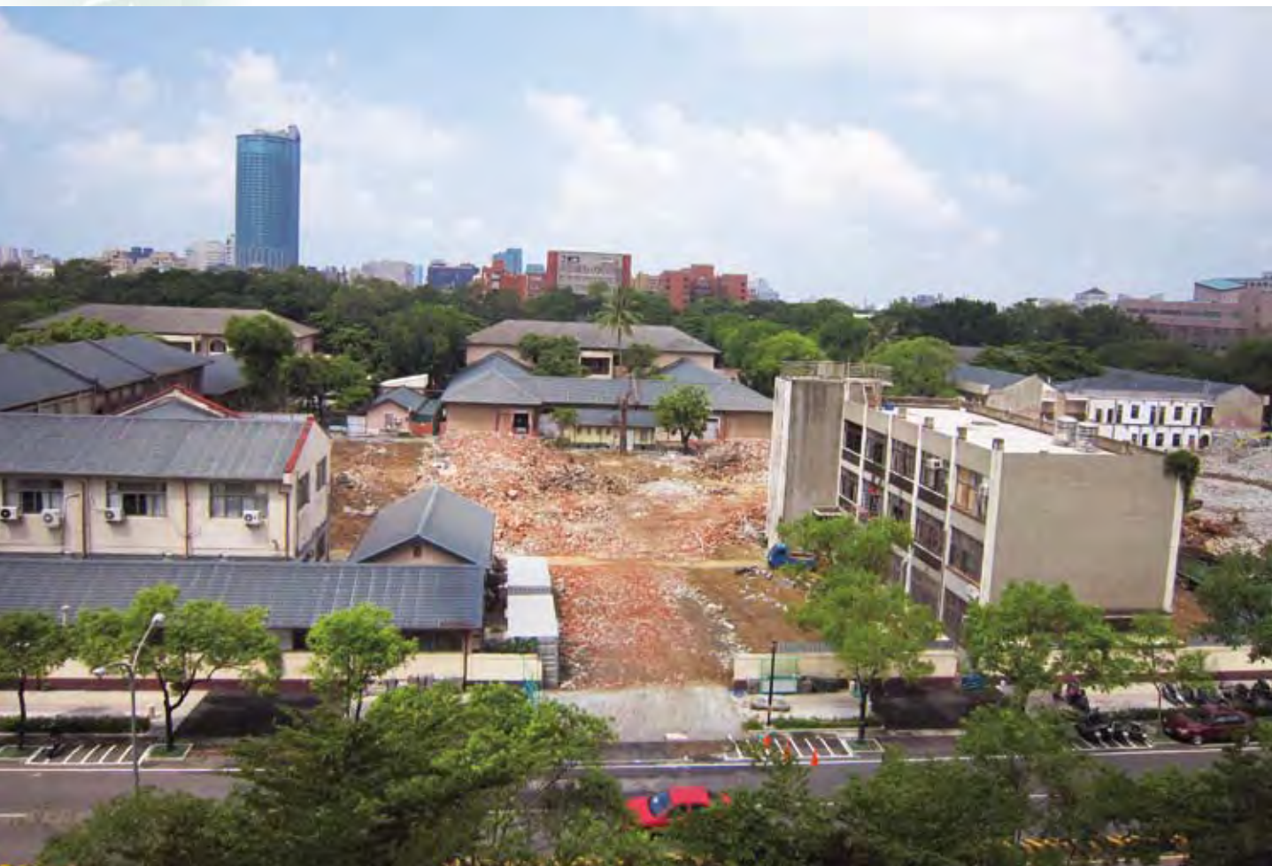
原化工系館(今資源工程系館)後半部改建中。照片中央是系館前半部，左側中間是原單元操作實驗室，其下方是原單元程序實驗室；右側是於1971年竣工之三層樓建築。
