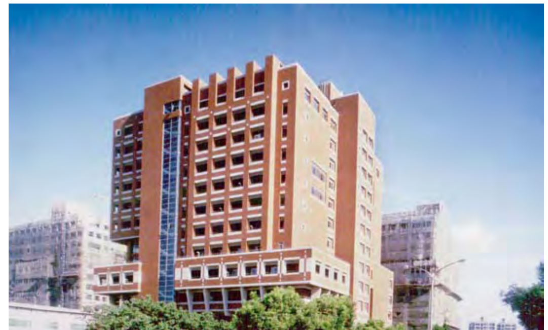
1995年竣工；照片左、右二側各為興建中之機械和電機新系館；新化工系館。
