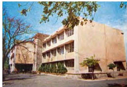
1968年竣工後之工程科學研究中心外觀(位於成功校區中央，後改為測量系館)。
