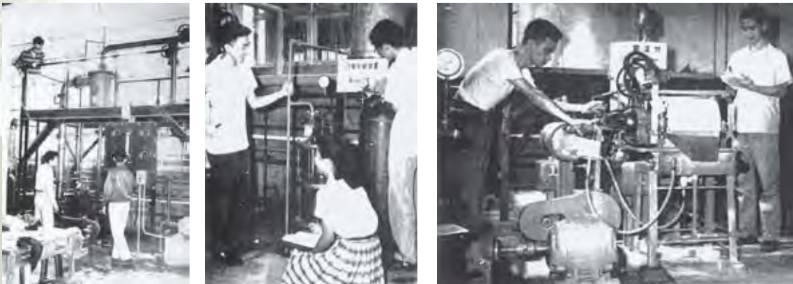
單元操作實驗(民國51年)。 單元操作實驗-泡罩示範裝置 (民國48年)。 單元操作實驗-圓濾機(民國48年)。
